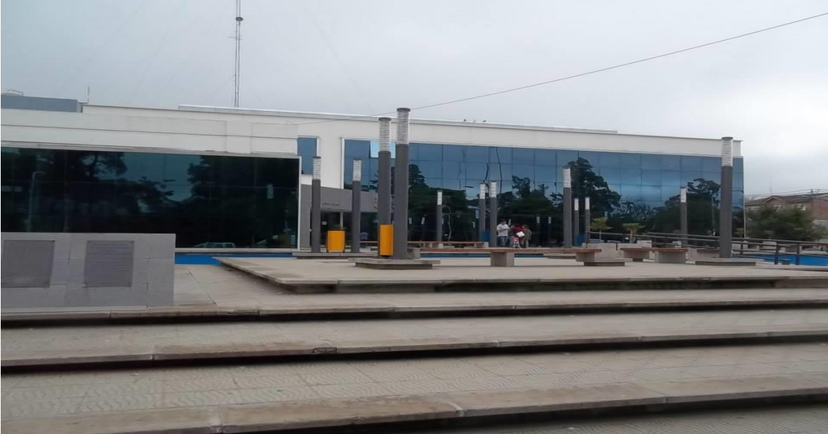
Fotografía exterior IV edificio Municipal de Lincoln
