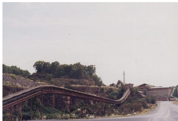
Figura 5. 2.: Cinta transportadora. Trayecto desde cantera hacia la planta industrial.
