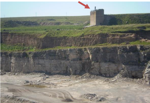
Figura 13. 2.: Horno Vertical. Cantera de La Providencia.
