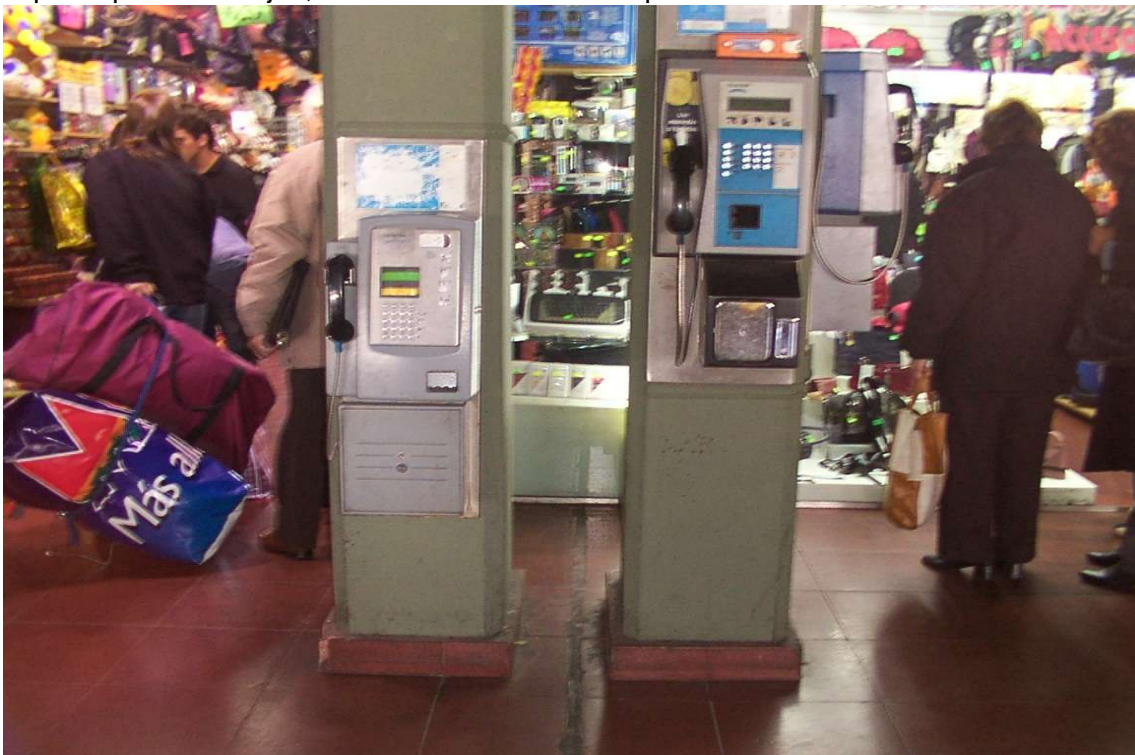
24- El teléfono público ubicado a nuestra izquierda es más bajo, especial para discapacitados motores en silla de ruedas o enanos.
