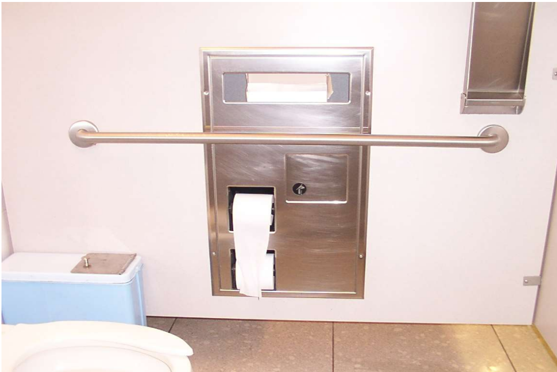
21- Barra de apoyo en el sector donde se localiza el papel higiénico.
