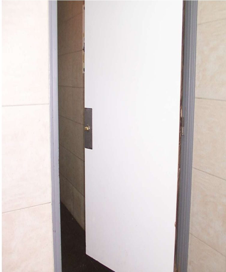
21- Puerta del baño accesible, foto sacada desde el interior del mismo. Podemos ver que abre hacia afuera y es más ancha, superior a 0,80 metros.
