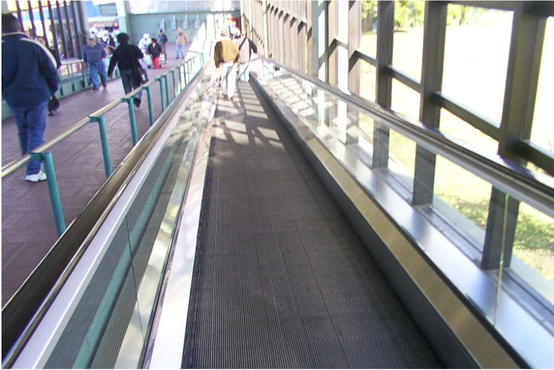
37- Solado de goma y relieve de la rampa mecánica de descenso que comunica al exterior de la terminal.
