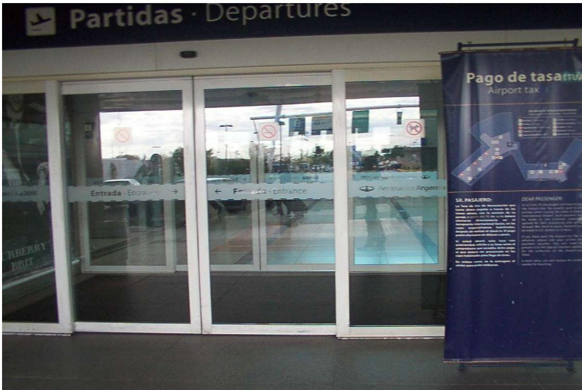
4- Esta fotografía muestra una de las puertas de entrada. Todas ellas son automáticas (se abren mediante sensores), de paneles de vidrio con franjas de color blanco en su punto medio. También tienen pictogramas sobre cosas que no están permitidas (entrada de mascotas, por ejemplo). Como se ve son dos puertas separadas por un pequeño hall.
