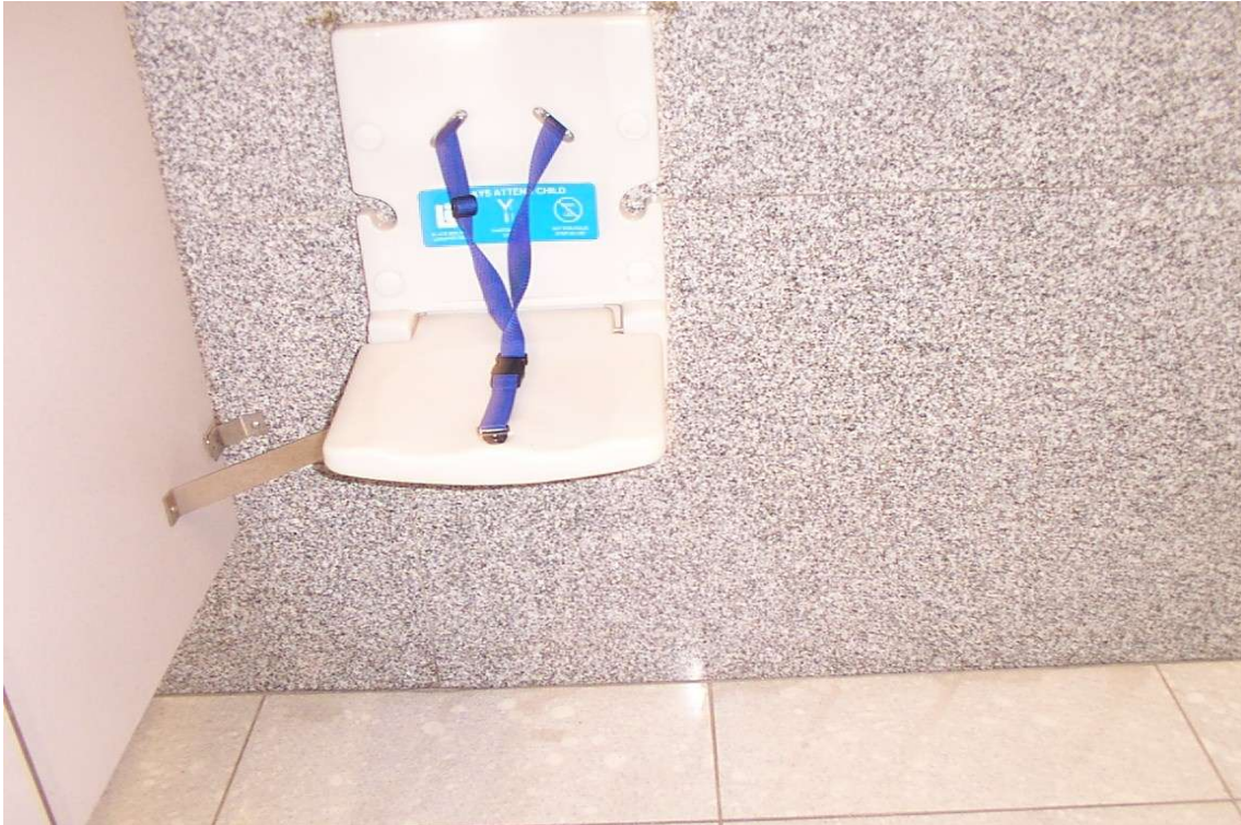
22- El sanitario adaptado consta de un asiento con sujeción para bebés y niños pequeños.
