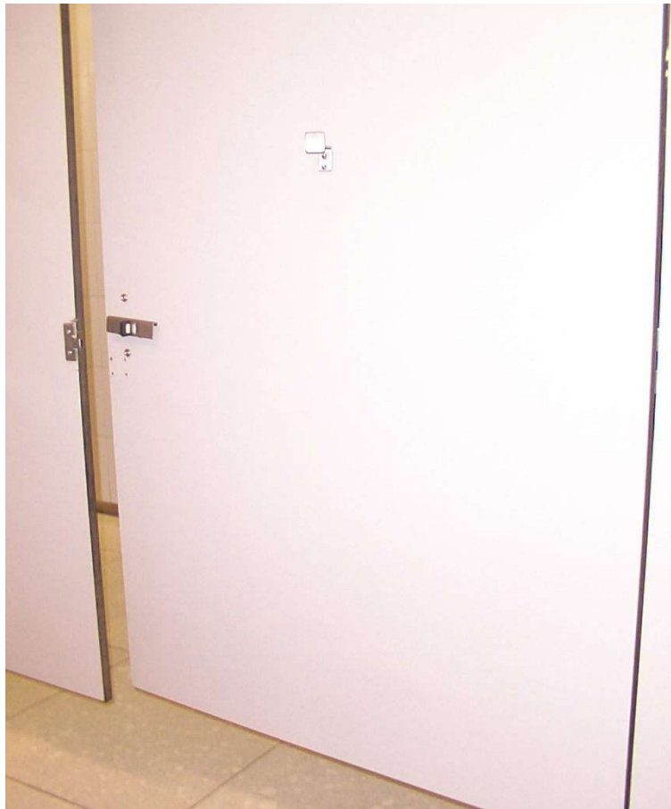
23- Puerta del sanitario accesible: superior a 0,80 metros de ancho, abre hacia afuera. El herraje y el gancho de colgar están a una altura apta para un usuario de silla de ruedas.
