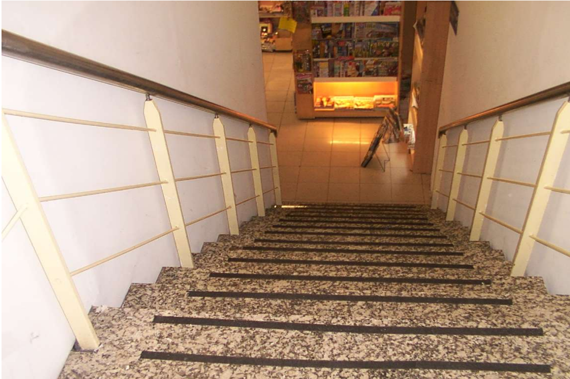
3- Escalera que comunica al sector de baños y teléfonos públicos. Podemos observar barandas en ambos lados y cintas de goma antiresbaladizas en sus escalones, no así solado con relieve, textura y color contrastante.
