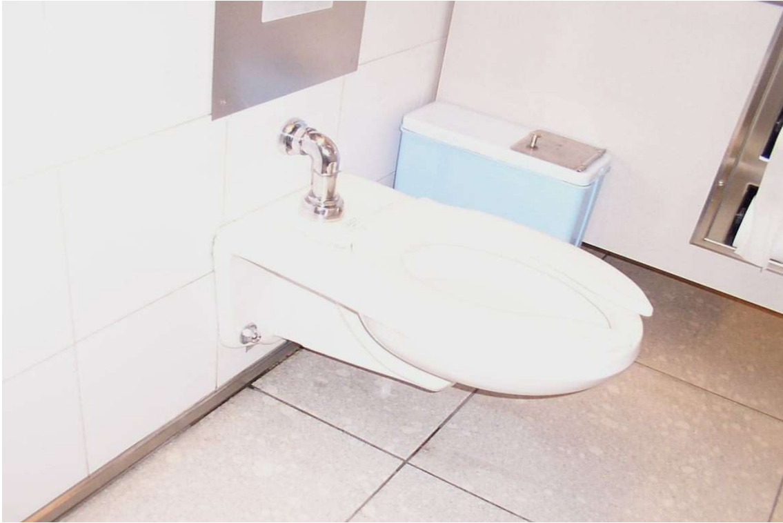
20- Interior del baño adaptado, vemos que la altura del inodoro es la adecuada, y que todos los elementos necesarios están al alcance.
