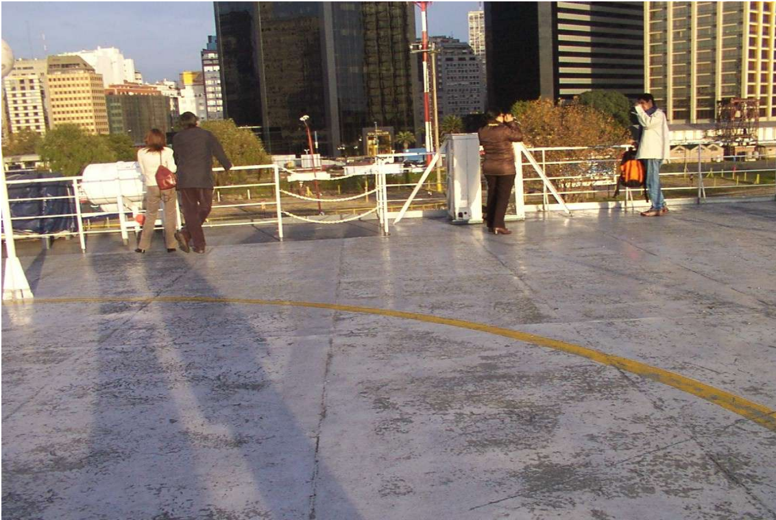
7- Algunos espacios tienen como medida de seguridad cadenas en lugar de baranda.
