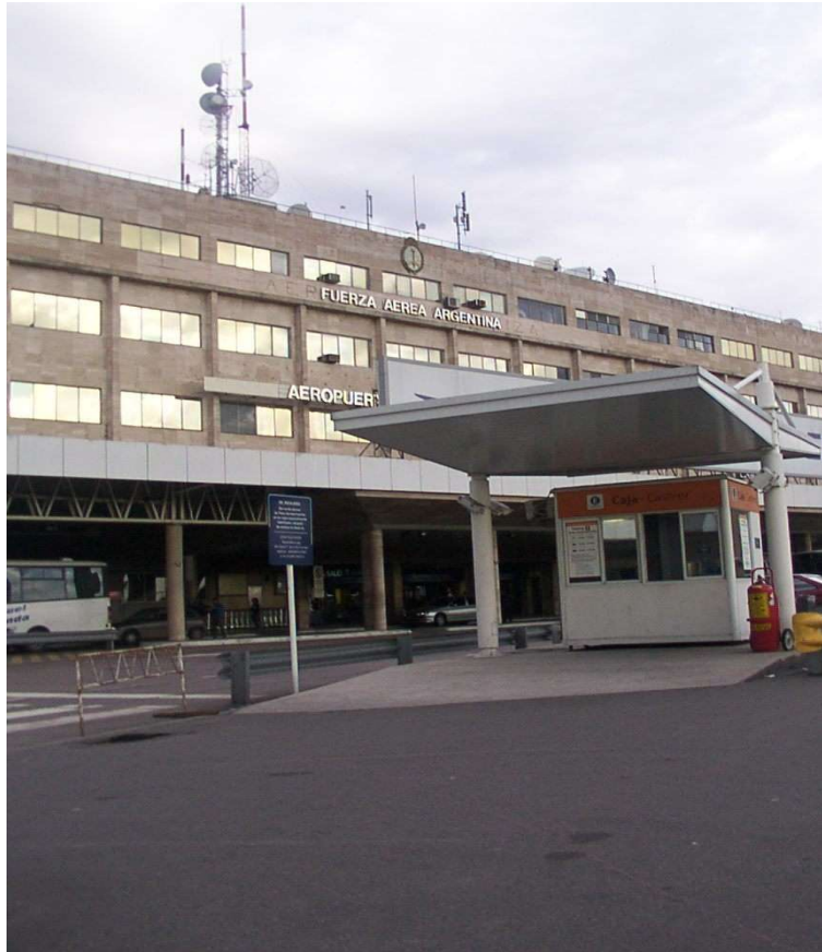
2- La construcción que se ve aquí es una de las oficinas de pago de tickets de estacionamiento, la cual consta de una rampa de pendiente suave, que se ve es de color diferente al resto del pavimento.
