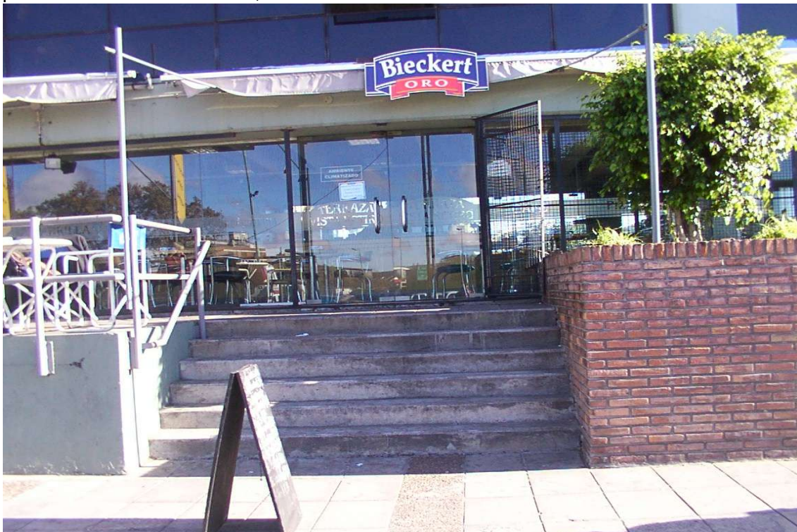
4- Restaurante de la terminal cuya entrada que da al exterior consta únicamente de escalones para su ingreso.
