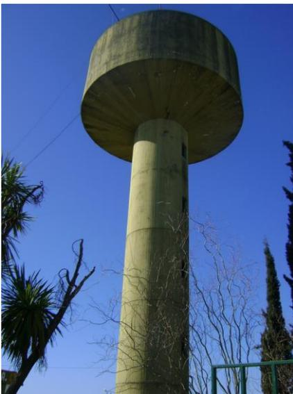
Allí se encuentra instalada la torre del tanque de depósito, la cual tiene por función mantener el agua por un día para la población, midiendo 22 metros y con una capacidad de 250.000 litros
