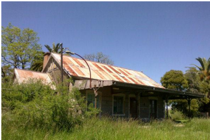
Figura 19. Estación Las Pipinas
