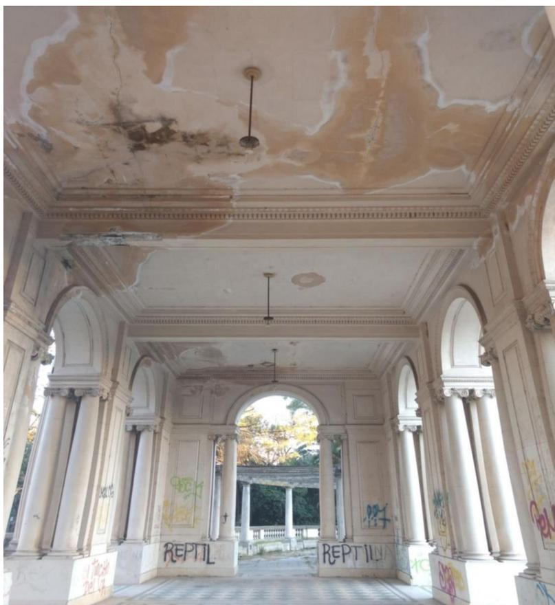
Figura n° 7. El interior del teatro, vandalizado, con signos de humedad y peligro de derrumbe. Fuente: artículo web 0221.
