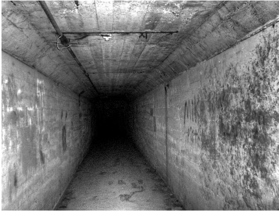
Túnel de la muerte donde se escuchan voces.
