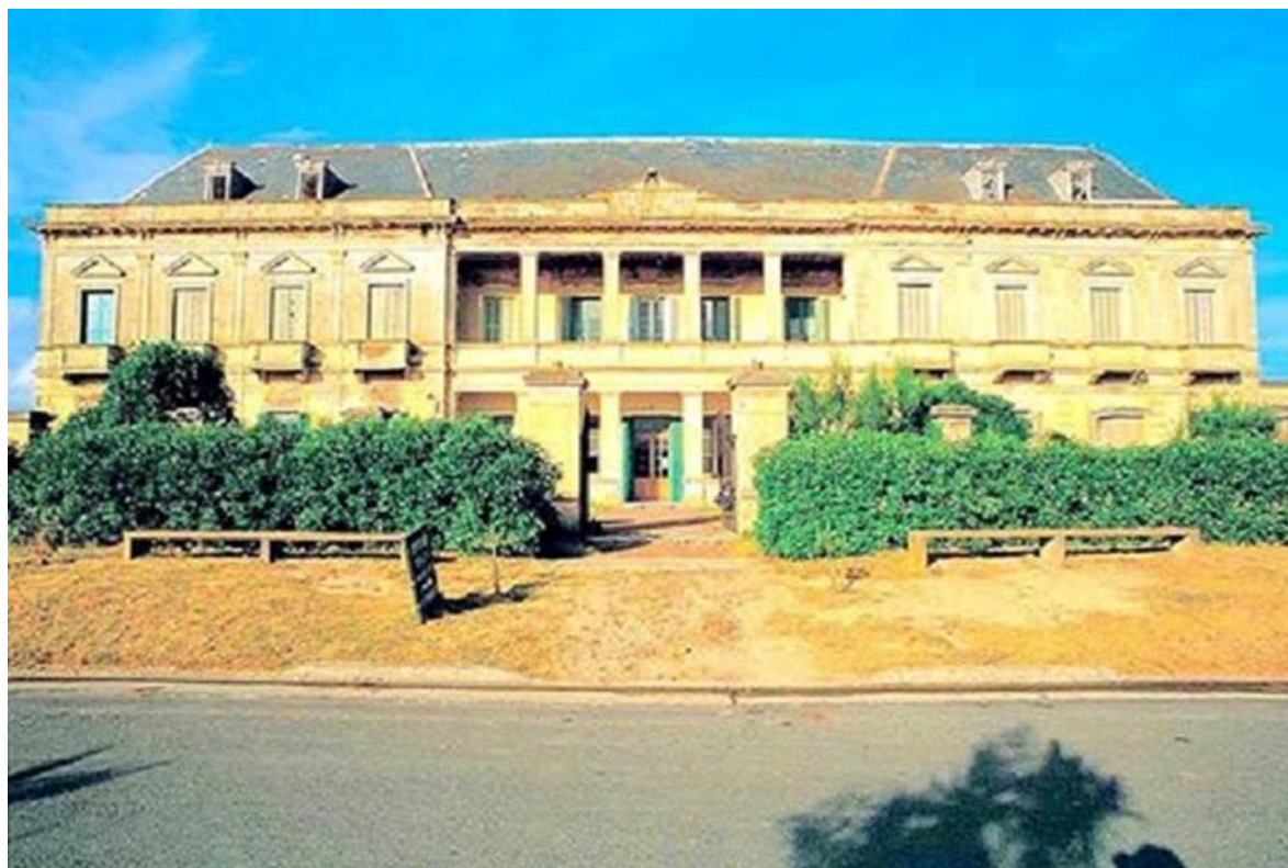
Fig. 19. El hotel en estado de abandono Fuente: Luis Fernando Somma
