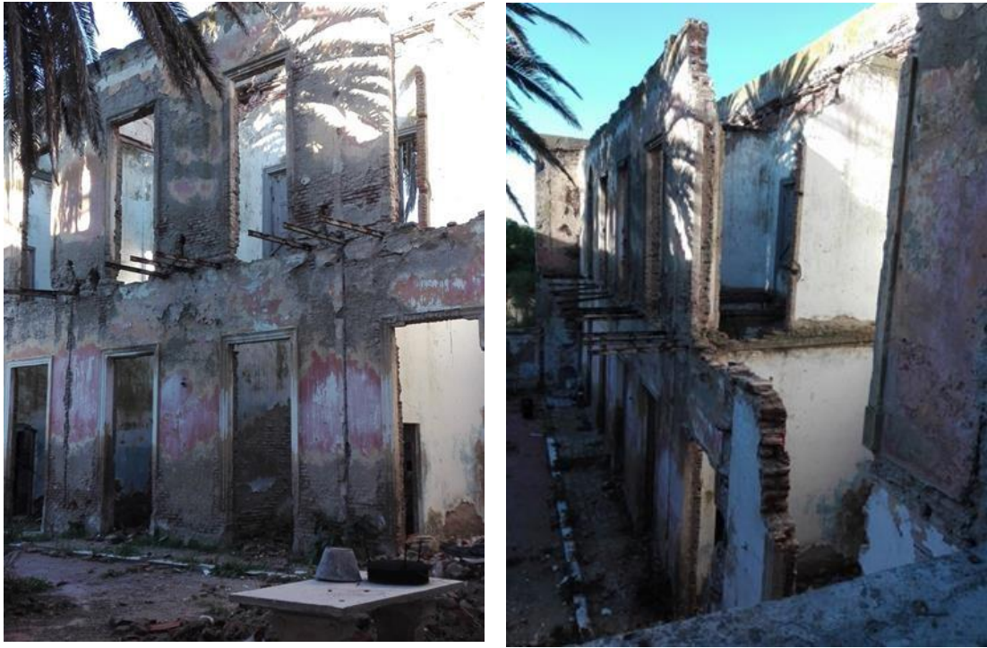
Fig. 22. Estado actual del edificio Fuente: propia
