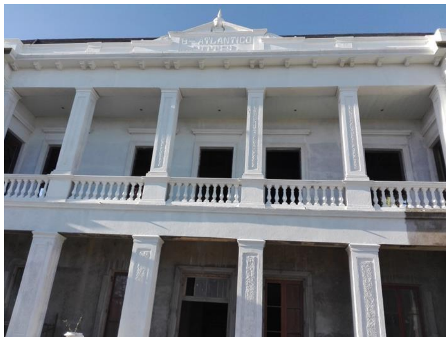
Fig. 21. Estado actual del edificio Fuente: propia
