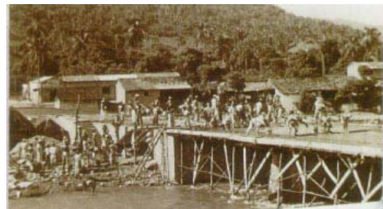
Imagen 15. Primer puente vehicular sobre el río Cuale.
